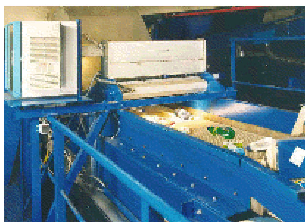
Abb. 5 Anlage criterion plus, Bandzuführung zur Meßkopfzeile
